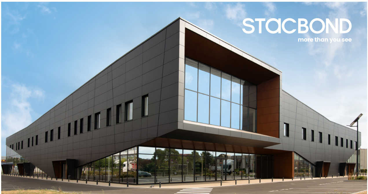
Bonneuil Sur Marne | office complex | France | STB-425
